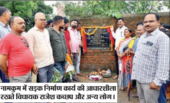
नामकुम में सड़क निर्माण कार्य की आधारशीला रखते विधायक राजेश कच्छप और अन्य लोग।
