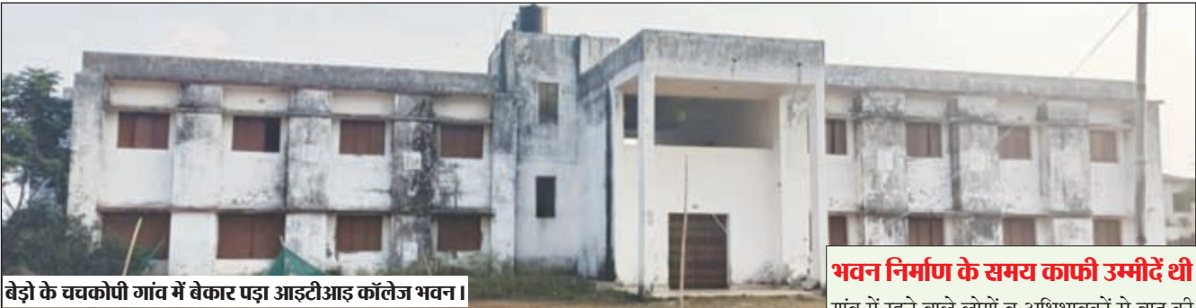
बेड़ो के चवकोपी गांव में बेकार पड़ा आइटीआइ कॉलेज भवन।
