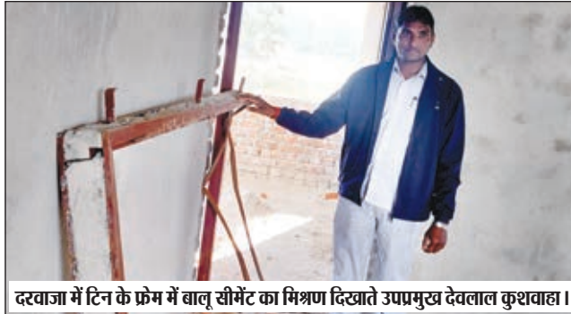
दरवाजा में टिन के फ्रेम में बालू सीमेंट का मिश्रण दिखाते उपप्रमुख देवलाल कुशवाहा।
