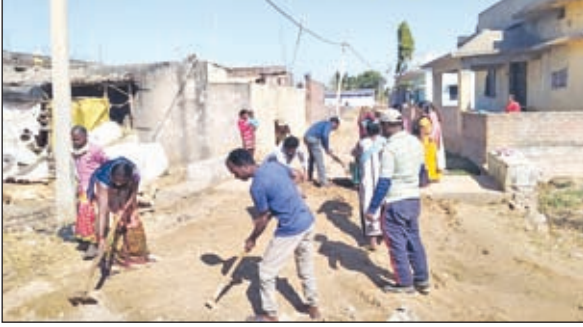
श्रमदान कर सड़क का निर्माण करते ग्रामीण
