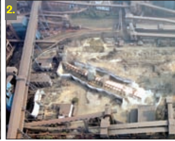
1. खड़ी 110 मीटर ऊंची चिमनी। 2. कंट्रोल इंप्लोजन के बाद ध्वस्त चिमनी और 3. सफल ऑपरेशन की जानकारी देते टाटा स्टील के वीपी अवनीश गुप्ता। साथ में वीपी चाणवर्य चौधरी और कान्ट्रेक्ट पार्टनर।
