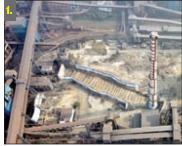
1. खड़ी 110 मीटर ऊंची चिमनी। 2. कंट्रोल इंप्लोजन के बाद ध्वस्त चिमनी और 3. सफल ऑपरेशन की जानकारी देते टाटा स्टील के वीपी अवनीश गुप्ता। साथ में वीपी चाणवर्य चौधरी और कान्ट्रेक्ट पार्टनर।
