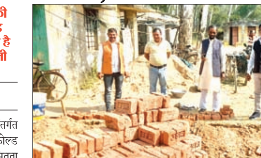
कोल्ड स्टोर निर्माण कार्य की निरीक्षण करते जनप्रतिनिधि ।
